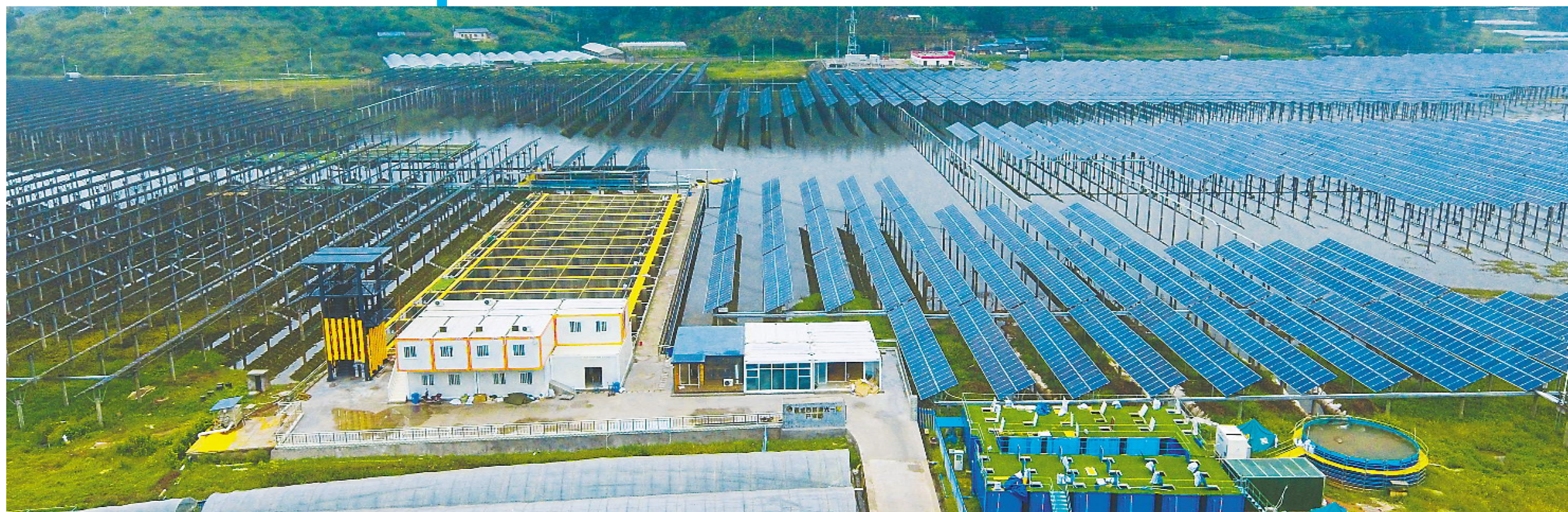
通威西昌“渔光一体”基地
