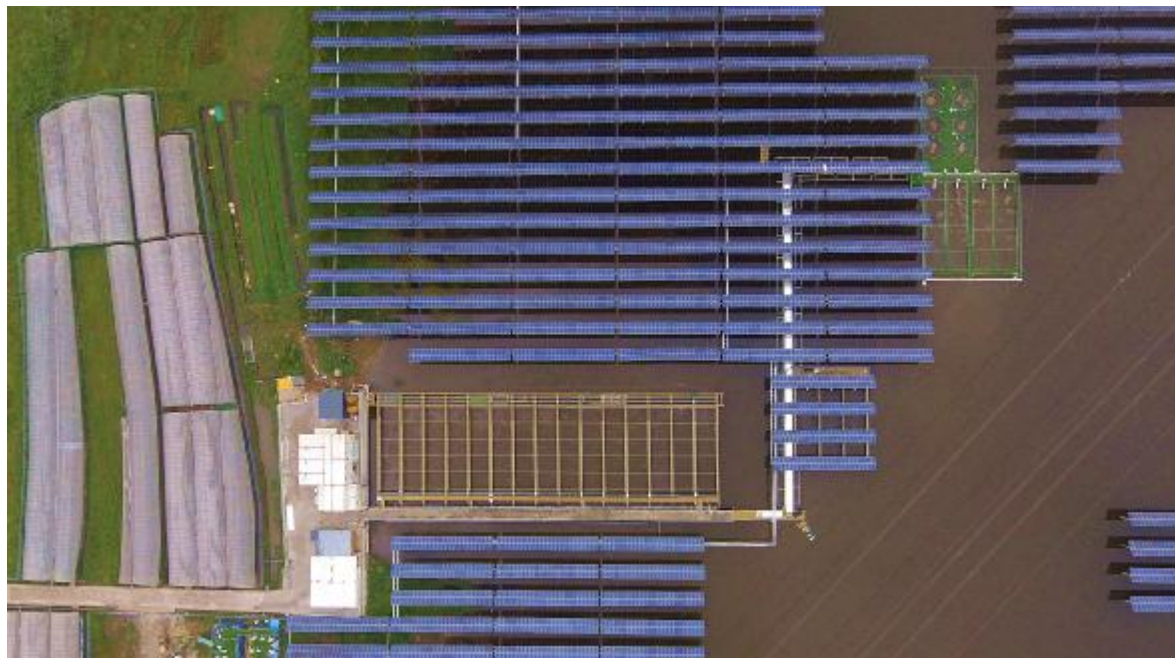
通威西昌“渔光一体”基地
