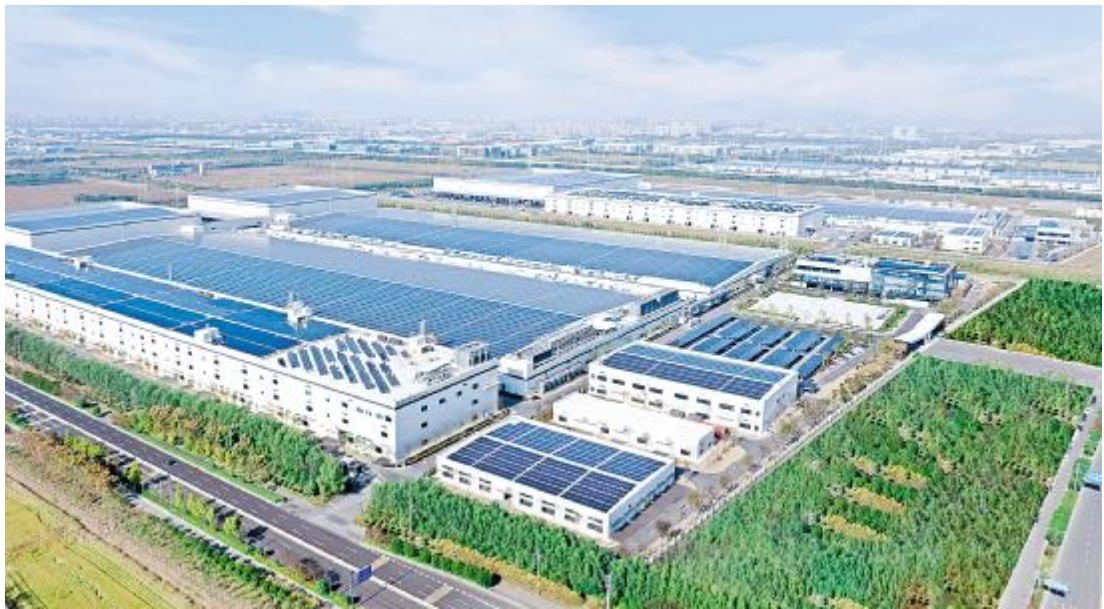
通威太阳能科技盐城基地71MW屋顶光伏项目
